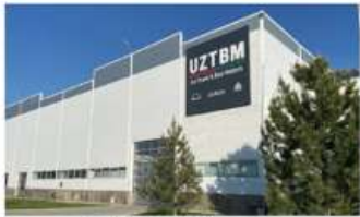
乌兹别克合资工厂 JV factory, Uzbekistan
